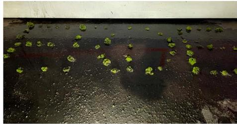
Eine gezielte, schnelle und wirksame Intervention, um die Vorstellungskraft für die Möglichkeiten eines Ortes zu unterstützen. Löcher mit 2-3 cm Durchmesser, hergestellt mit Akkubohrer, gefüllt mit Erde und Saatgut. Die Löcher formen Buchstaben oder Icons und werden sukzessive zu einer gut sichtbaren, grünen Botschaft. Ein Versprechen für die weitere Entsiegelung dieser Fläche. Wir haben mit Moos bzw. mit Kresse-Samen nachgeholfen, den Rest macht die Natur selbst.
